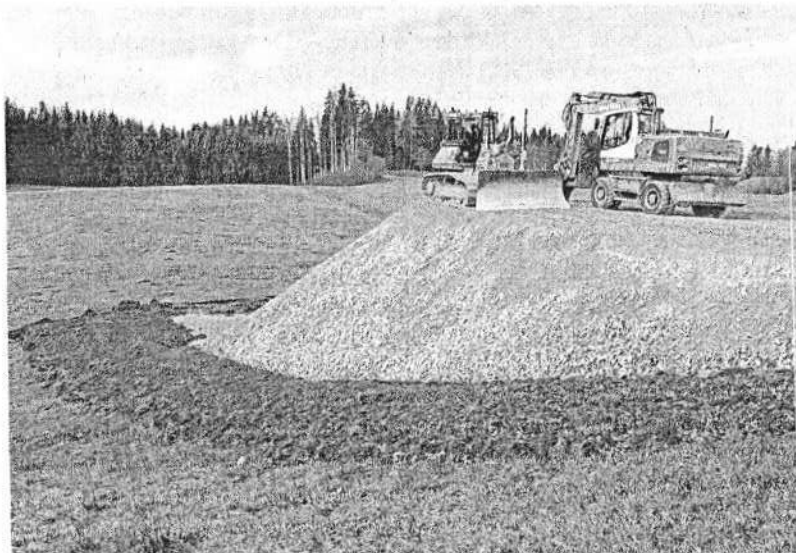
Neben einem größeren Kieshügel deuten seit einigen Tagen auch zwei Baumaschinen auf den Beginn der Erschließungsarbeiten in der Au zwischen Gestratz und Grünenbach hin. Foto: Olaf Winkler
