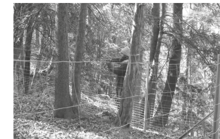
Glücksspirale-Projekt, Bau der Weiserzäune
